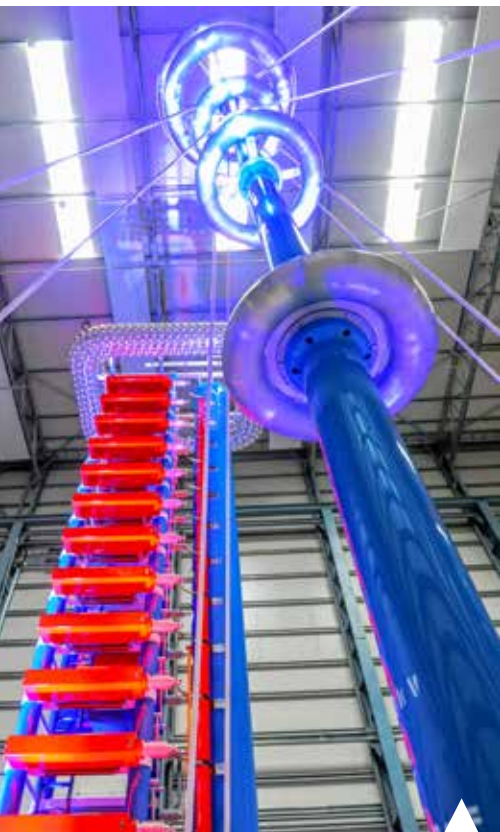
I test di sistemi e cavi HVDC sono il "fiore all'occhiello" del laboratorio CESI di Mannheim
